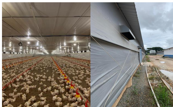
Figura 2 – Área interna e externa de sistema climatizado completo. Arquivo Pessoal.
